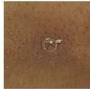
f) costra parcialmente eliminada
